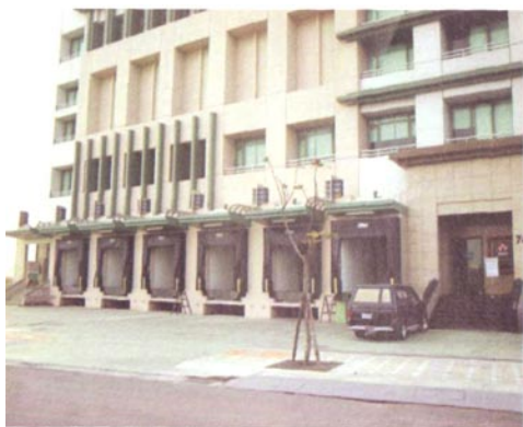
封闭式码头室外侧
