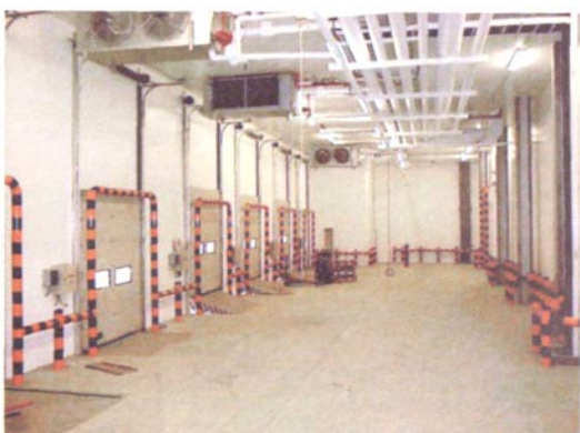
封闭式码头室内侧
