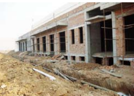
土建结构冷库
